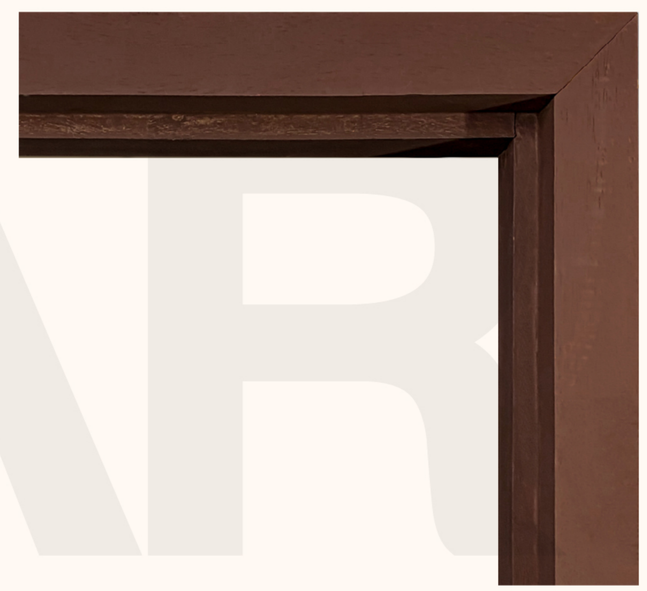
ระยะวงกบหลังไส Distance of the jamb after planing.
